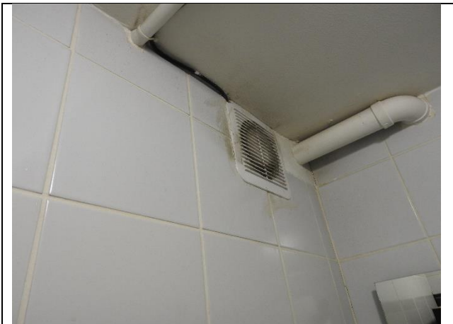
Extracción de Baños
