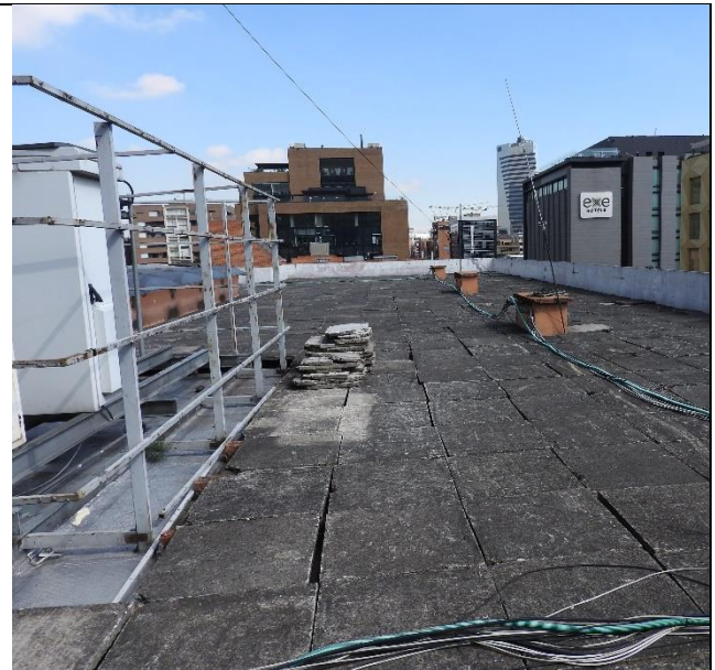
Cubierta del edificio
